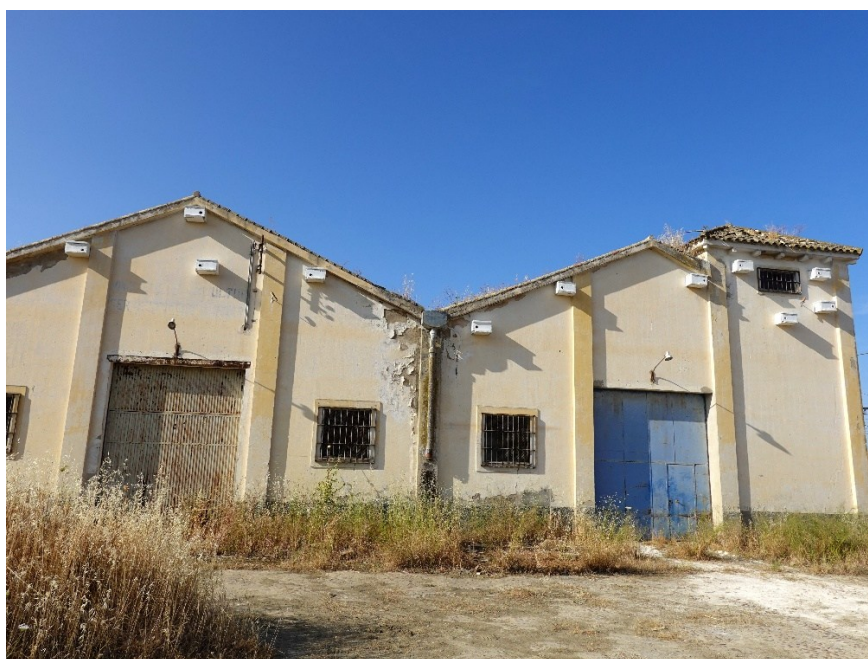
Figuras 7 a 9. Instalación de cajas nido en la fachada norte de la nave. Fotos: Diego Jordano
